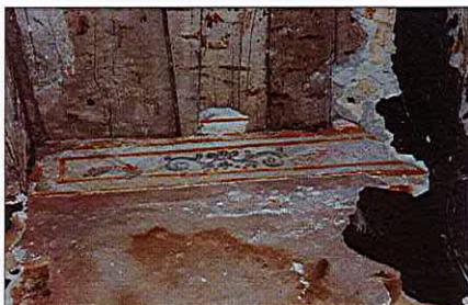
1 - Détail décors peints probablement du début XVIIIème plafond du 3ème étage
