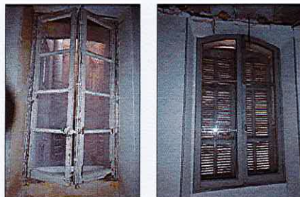
4 - Fenêtres du deuxième et troisième étage
