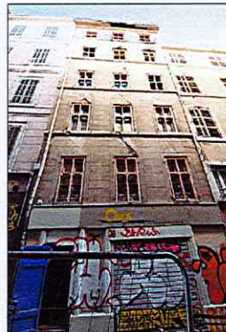
Façade sur la rue Roque
