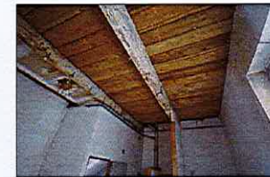
Mise à nu des planchers
