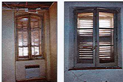
5 - Fenêtres du troisième étage
