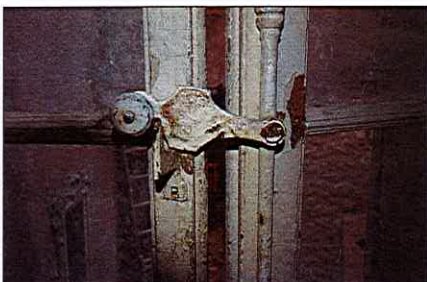
3 - Détail espagnolette d'une fenêtre du deuxième étage
