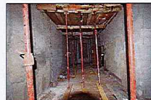
Retrait partiel du remplissage de la voûte
