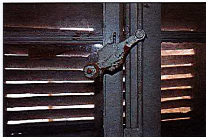
6 - Détail espagnolette d'une fenêtre du quatrième étage
