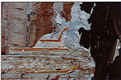
2 - Détail décors peints probablement du début XVIIIème plafond du 3ème étage
